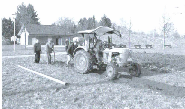
Legen eines Kanalrohres für Strom
